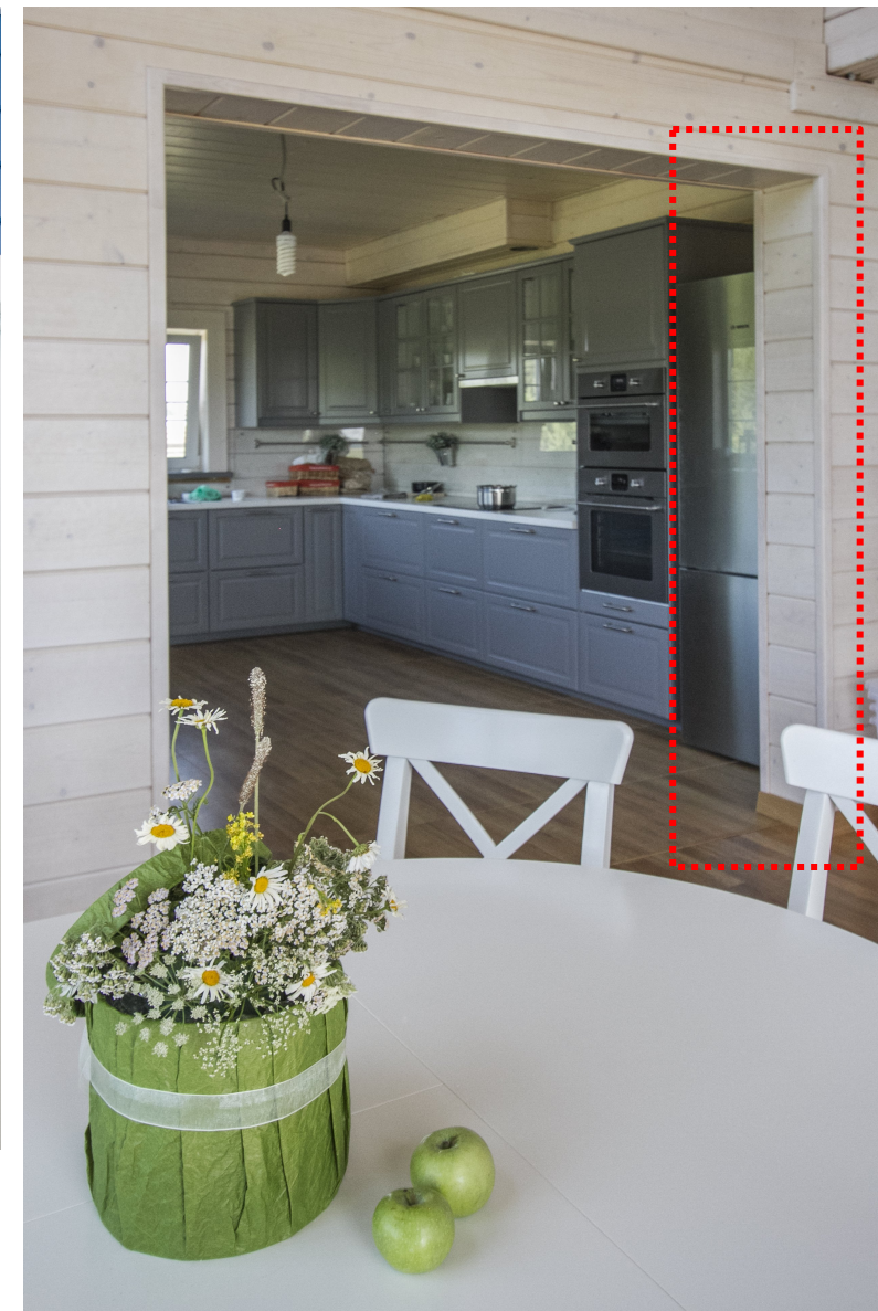
Стыковка отделки во внешнем углу из имитации бруса производится через деревянный уголок.
