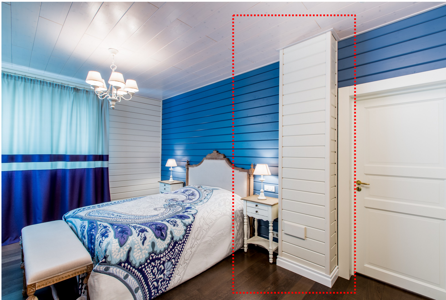
Стыковка отделки во внешнем углу из имитации бруса производится через деревянный уголок.
